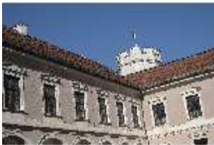
EiW.I, Gemmingenbau, Innenhof, DI033592, BSV-
