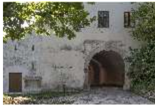
EiW.I, Torbau, Äußeres Tor (AF 1), DI033604, BSV-
