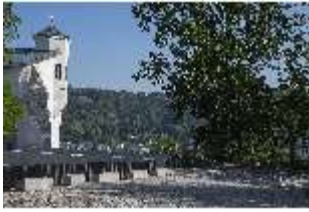
EiW.I, neue Brücke über den Burggraben zum Schaubergbau, DI033566, RSV-
