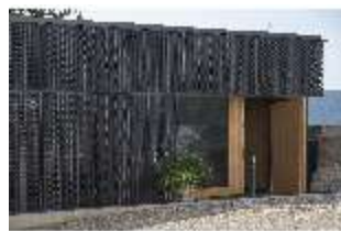
EiW.I, Neubau des Kassen- und Servicegebäudes, DI033596, BSV-
