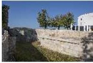
EiW.I, Blick in den Burggraben, DI033563, BSV-
