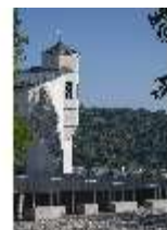
EiW.I, neue Brücke über den Burggraben zum Schaumbergbau, DI033565, BSV-
