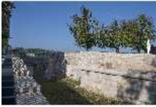
EiW.I, Blick in den Burggraben, DI033560, BSV-
