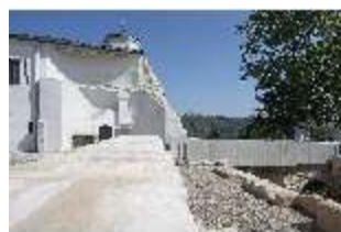
EiW.I, neue Brücke über den Burggraben, DI033577, BSV-
