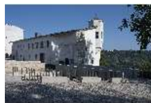
EiW.I, neue Brücke über den Burggraben zum Schaumbergbau, DI033564, BSV-
