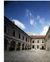
EiW.I, Innenhof, Gemmingenbau, DE003439, BSV-
