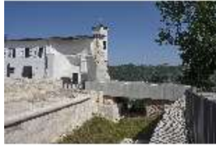
EiW.I, neue Brücke über den Burggraben zum Schaubergbau, DI033571, RSV-
