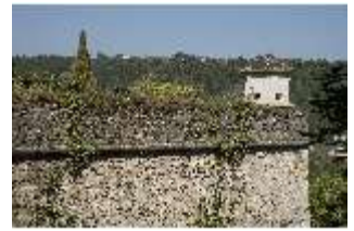
EiW.V, Blick auf die Mauer des Bastionsgarten, DI033609, BSV-
