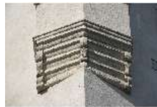
EiW.I, Schaubergbau, Detail des Erkers, DI033580, BSV-
