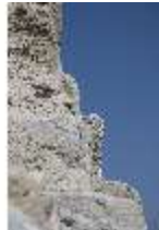
EiW.I, Detail vom Mauerwerk, DI033586, BSV-
