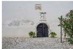
EiW.I, Gemmingenbau, Toröffnung mit Wappen, DI033585, BSV-
