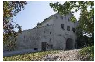
EiW.I, Torbau, Äußeres Tor (AF 1), DI033606, BSV-
