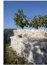
EiW.I, Blick in den Burggraben, DI033559, BSV-
