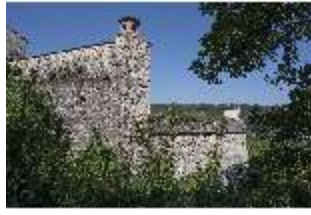
EiW.I, Blick auf die Bastion, DI033515, BSV-
