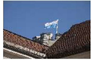
EiW.I, Dächer des Gemmingenbaus, DI033588, BSV-
