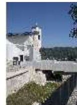
EiW.I, neue Brücke über dem Burggraben, DI033561, BSV-
