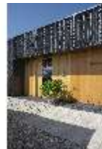
EiW.I, Neubau des Kassen- und Servicegebäudes, DI033597, BSV-
