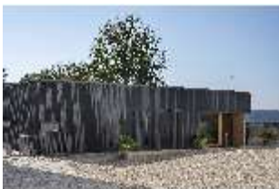
EiW.I, Neubau des Kassen- und Servicegebäudes, DI033595, BSV-
