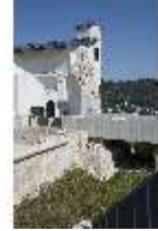
EiW.I, neue Brücke über den Burggraben zum Schaubergbau, DI033569, RSV-
