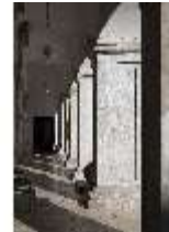
EiW.I, Gemmingenbau, Erdgeschossloggia im Innenhof, DI033537, BSV-
