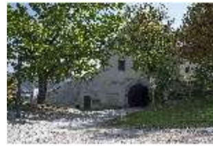
EiW.I, Torbau, Äußeres Tor (AF 1), DI033605, BSV-
