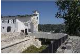
EiW.I, neue Brücke über den Burggraben zum Schaubergbau, DI033570, RSV-
