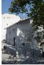
EiW.I, neue Brücke über den Burggraben zum Schaubergbau, DI033567, RSV-
