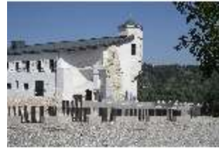
EiW.I, neue Brücke über den Burggraben zum Schaubergbau, DI033568, RSV-
