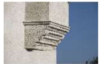
EiW.I, Schaubergbau, Detail des Erkers, DI033581, BSV-
