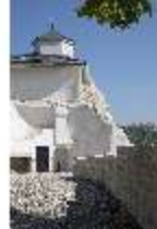
EiW.I, neue Brücke über den Burggraben zum Schaubergbau, DI033576, RSV-
